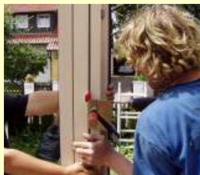
7. Nun werden die Fensterelemente mit umlaufenden Quellband versehen, eingesetzt und verschraubt.
