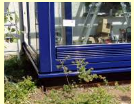
8. Mit Dichtbändern werden abschließend Wand- und Bodenanschlüsse wasserdicht hergestellt.
