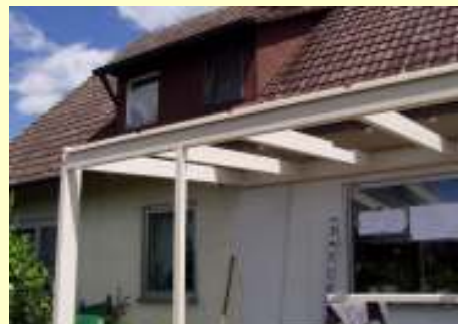
2. Danach werden Traufpfette und Hilfspfosten befestigt, die Feldsparren im Dach eingeschlagen ...
