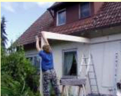
1. Nach Montage der Firstpfette werden Randsparren und Eckpfosten eingehängt und verschraubt.
