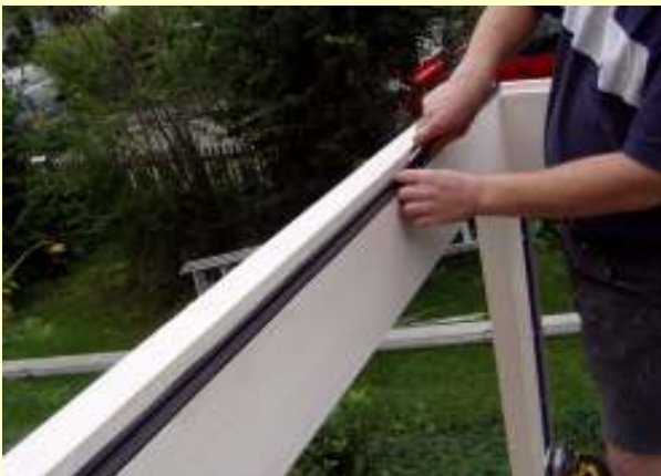
4. Vor dem Anbringen der Dachverglasung drückt man Auflagedichtungen in die Nuten der Dachsparren.
